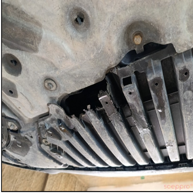
Ön tampon alt muhafazası hasarlı
