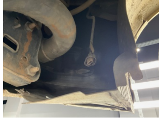
Elektrik donanımı/Pano, Kablo demeti > Onaysız
