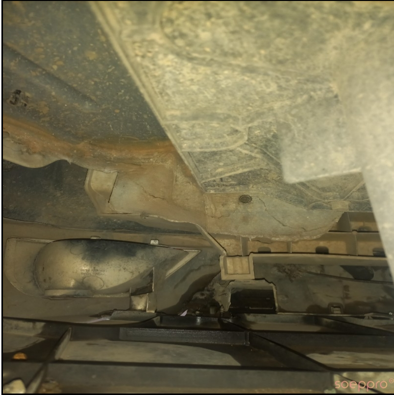
Arka panelin sağ köşesi ezik
