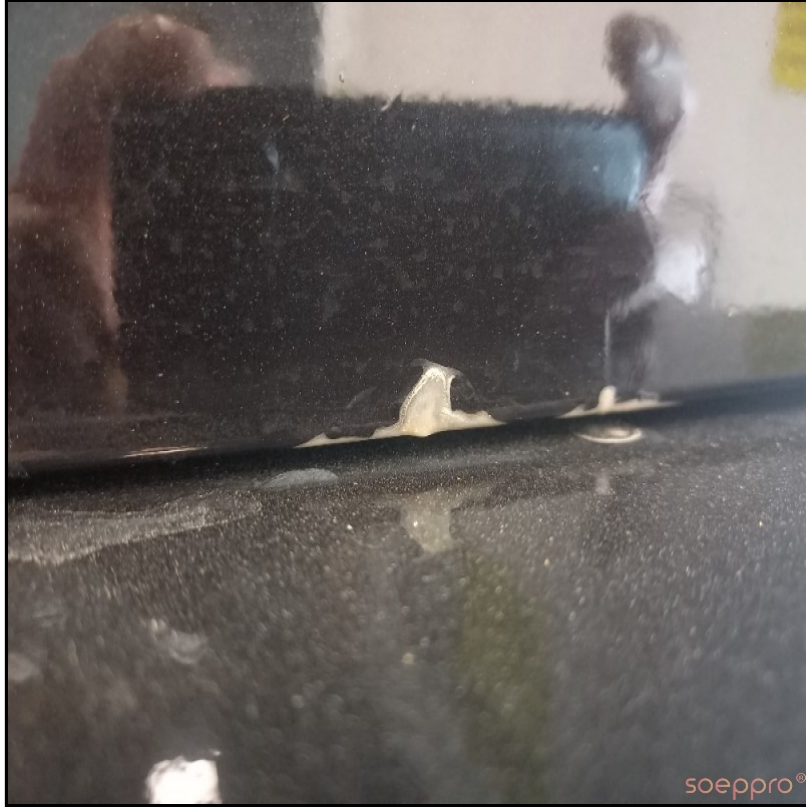
Bagak kapagi kaplamada deforme var
