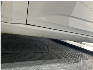
Marşbiyel, sol, Marşbiyel, sol > Hasarlı
