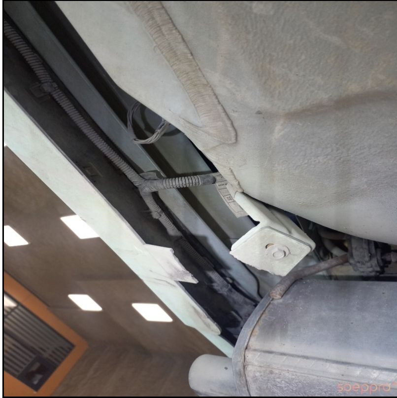
Arka tampon sol bağlantısı kırık
