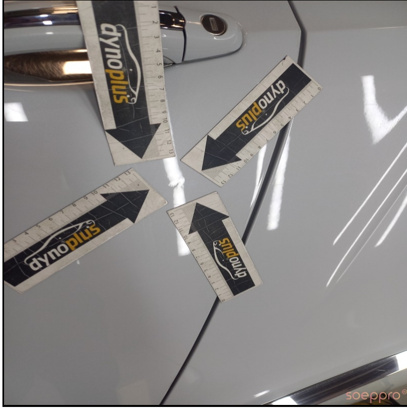
Sol ön kapıda kuru onarım işlemi var
