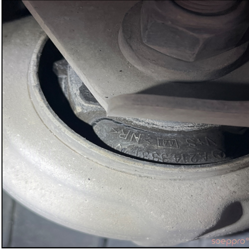
Ön alt salıncakta çatlaklar var
