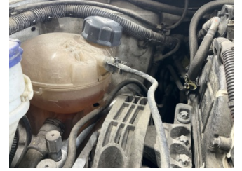
Motorsoğutması, Soğutma sıvısı > Eksik
